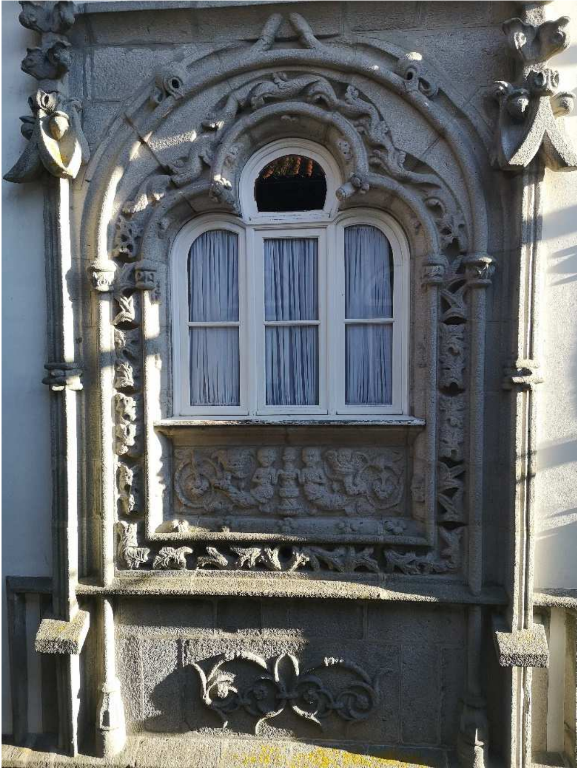
Fig. 5 -Janela Manuelina de uma casa em Viana do Castelo. Fotografia de Vasco Pimenta de Castro
